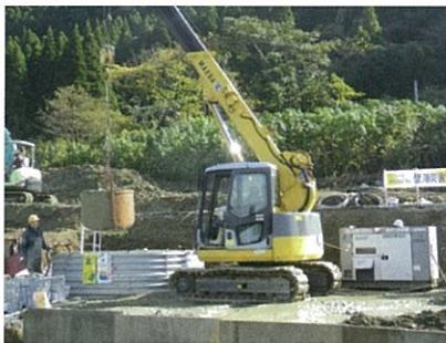
写真 3.1 クローラークレーン 4.9t による排土作業
