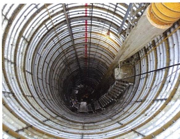
写真 3.5 地上から見た、深さ 50m 付近施工中の坑内状況マンションでいうと、20階建相当の高さ
