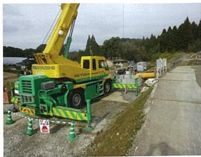
写真 3.4 ラフタークレーン 25t による
