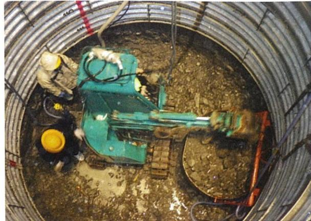
写真 3.6 電動バックホウ掘削状況
