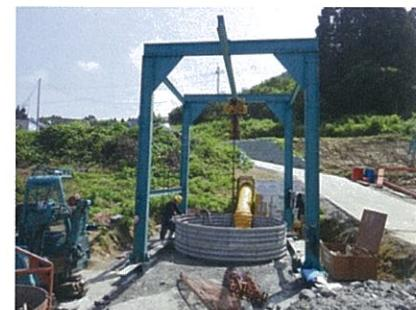
写真 3.3 固定式門型テルハクレーンによる排土作業
