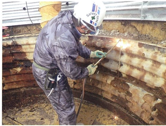
写真-9 高圧ガスによるライナープレート切断状況
