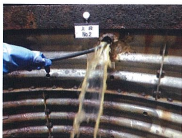
写真-5 洗浄状況
