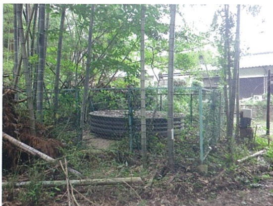
写真-1 施工集水井
