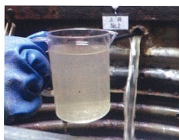
写真-7 第4回目洗浄状況
