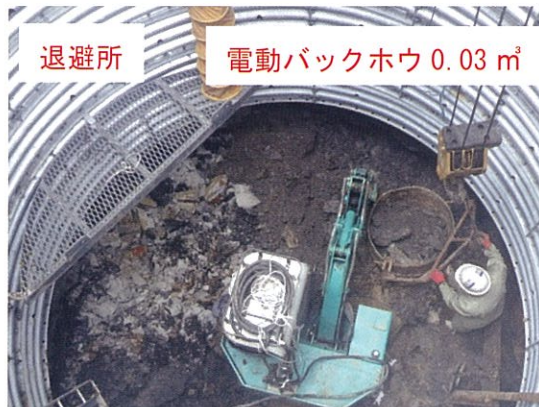
写真-11 坑内掘削状況
