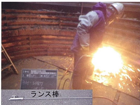
写真-10 ランス棒によるライナープレート切断状況
