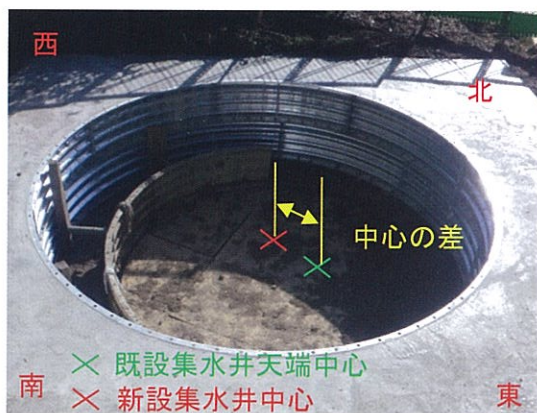
写真-4 既設と新設ライナープレートの 中心の差 D=407\text{ mm}
