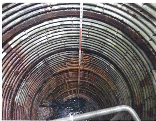
写真-2 集水井状況
