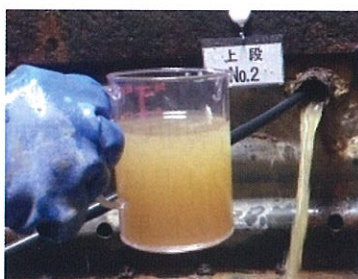
写真-6 第1回目洗浄状況
