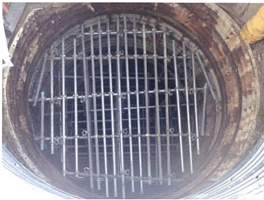
写真-8 足場仮設状況 GL-4m 付
