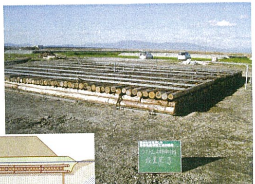
ラフト&パイル工法のイラスト(左)と外観(上)
