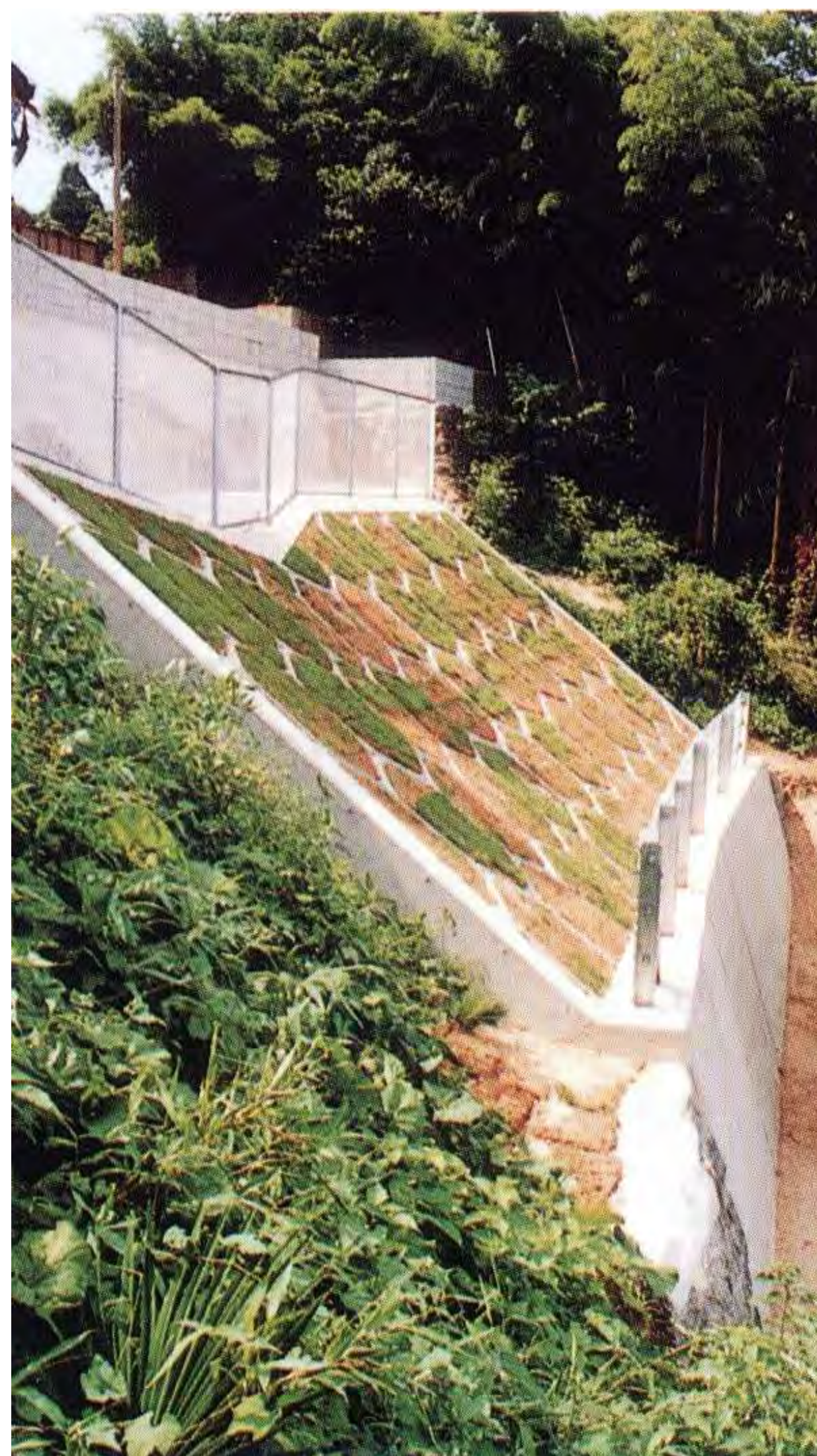
施工直後 (H12.3 完成)
