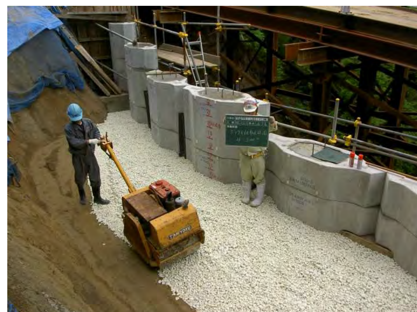
③ ミラクルソルの転圧状況
