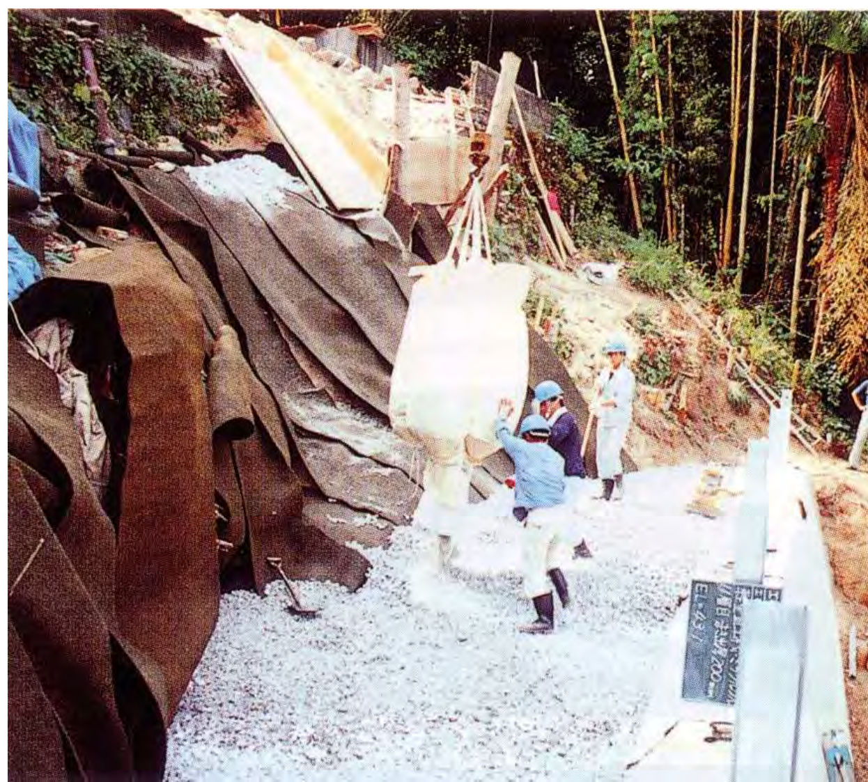
敷き均し状況
