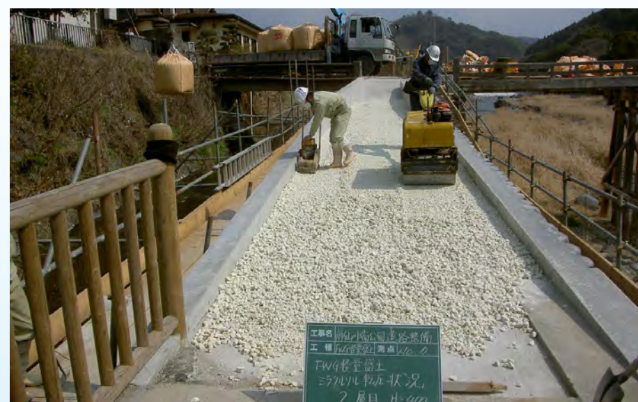
堤防の嵩上げ
