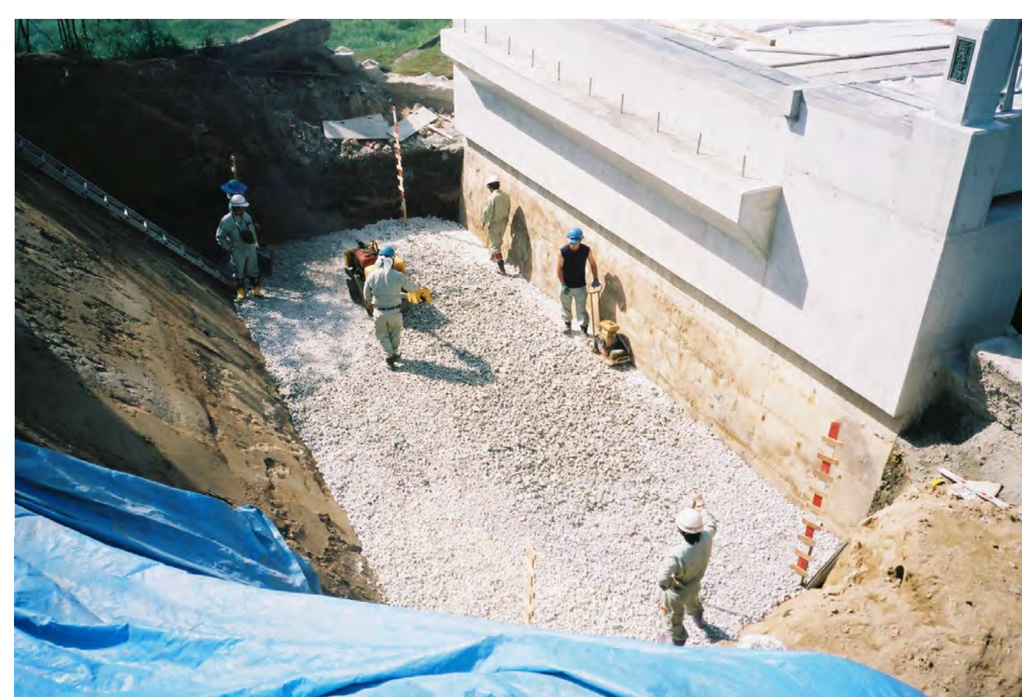
② ミラクルソルの転圧状況
