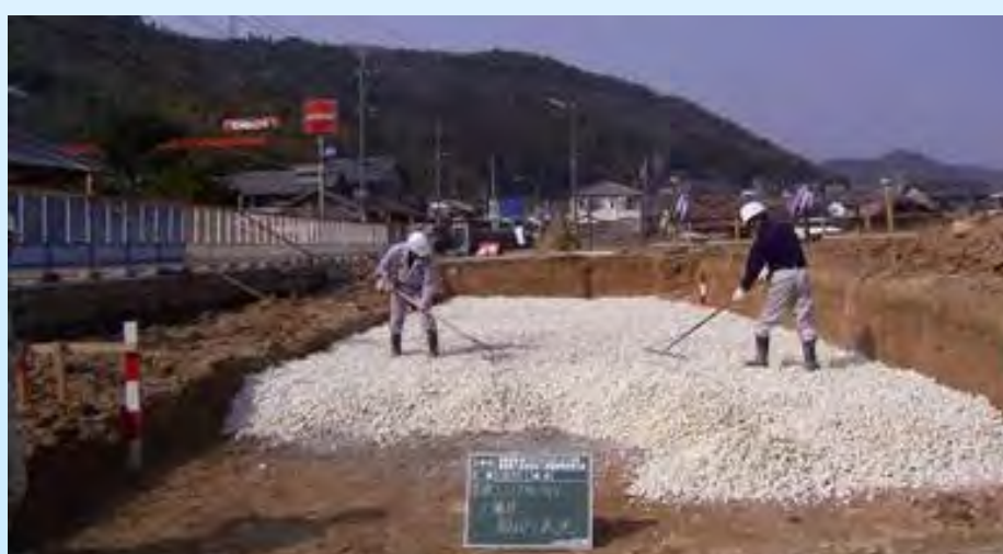
構造物の埋戻し（置換）
