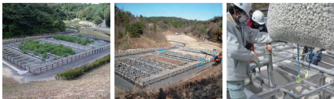
写真1-1 施工状況 写真1-2 施工完了 写真1-3 植生状況
