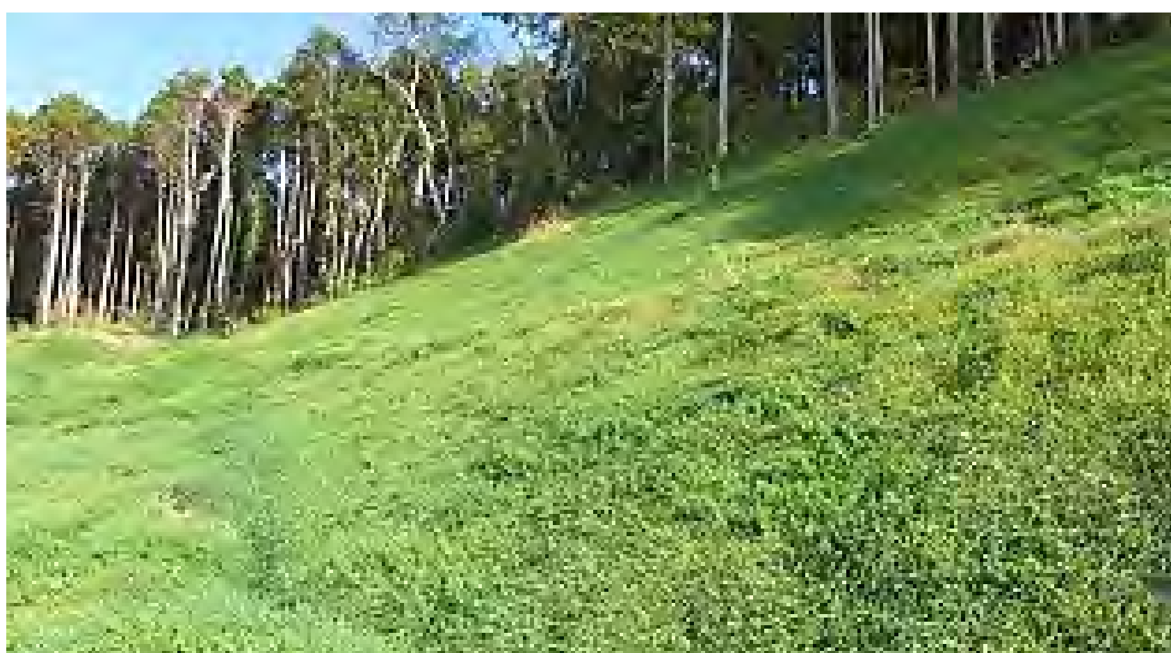
施工後1年8ヶ月（2022年11月）
