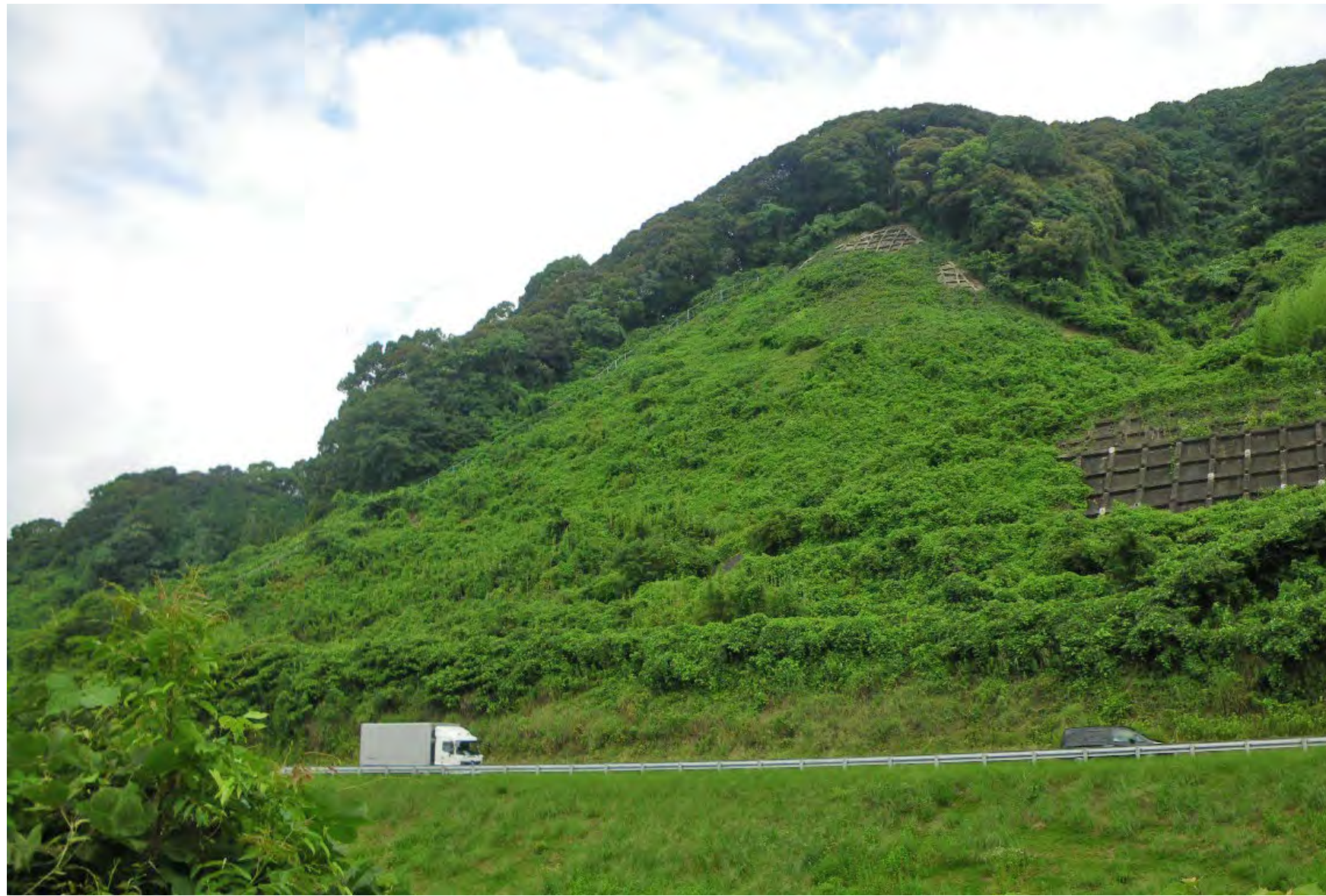
施工後4年の植生状況（2019年7月）
