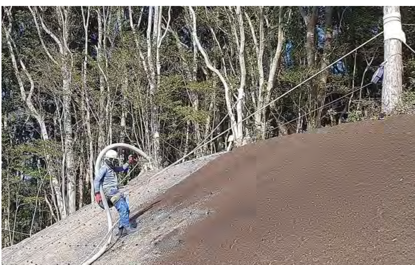
植生基盤材吹付状況
