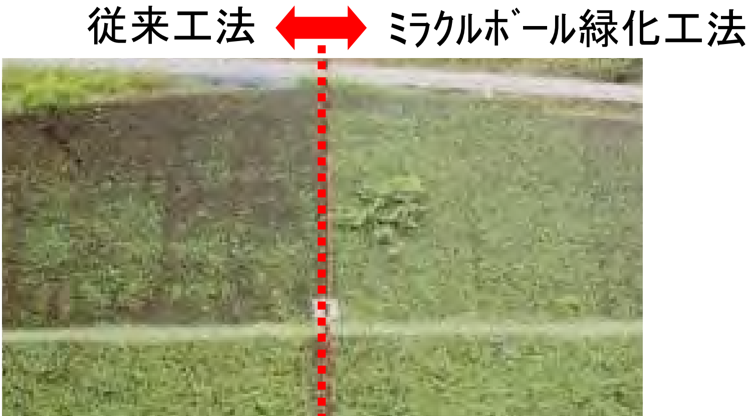
施工後45日の植生状況
