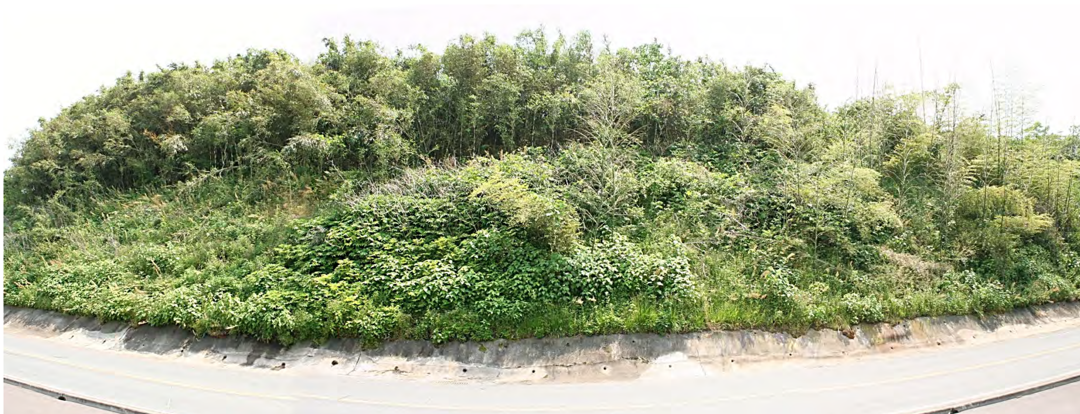
施工後10年6ヶ月 (2012年8月)
