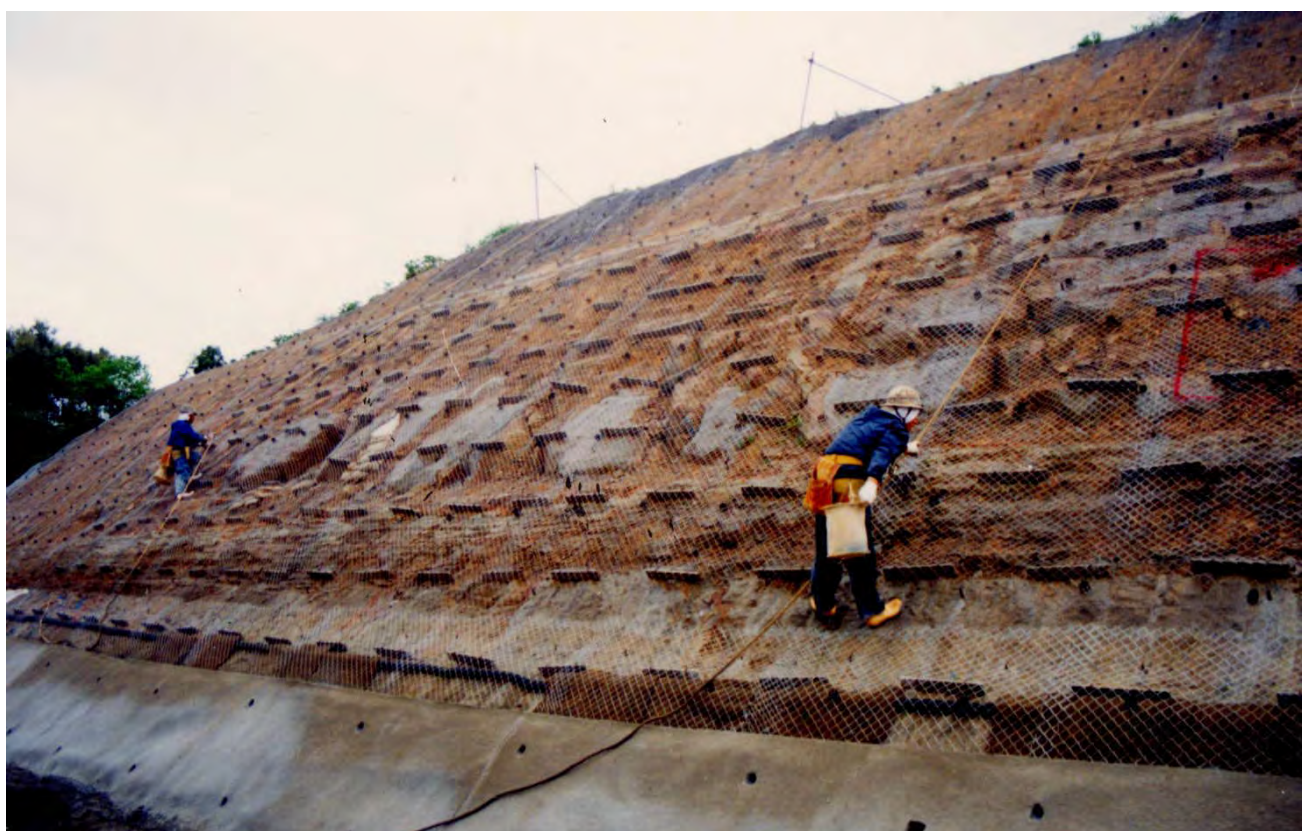
ラス張り状況
