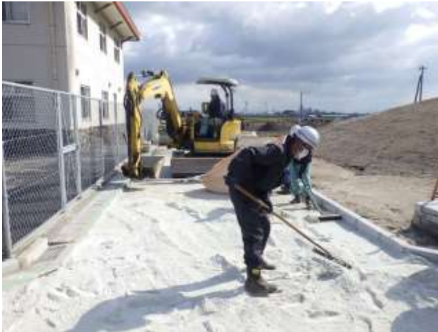
写真 I-⑤ フィルター層 (ミラクルソル WG-04) 2mm アンダー敷き均し状況
