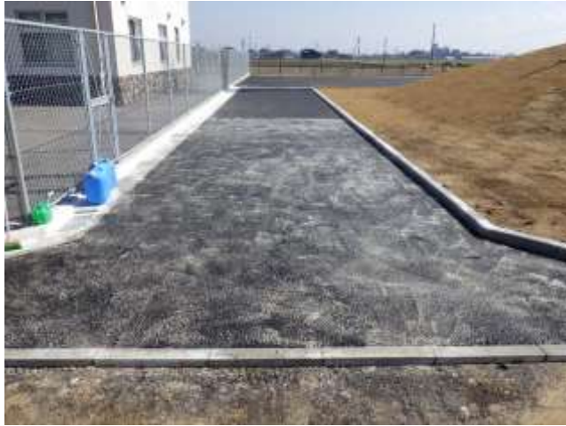
写真 1-⑨ 透・保水性舗装 2mm アンダー 間詰め完了
