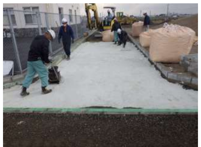
写真1-② フィルター層(ミラクルソル WG-04) 2mm アンダー敷き均し・転圧状況
