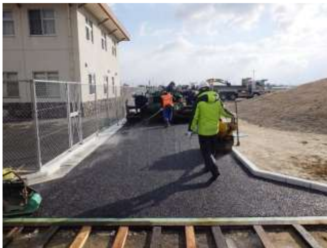
写真 I-⑦ 透水性舗装アスファルト打設状況
