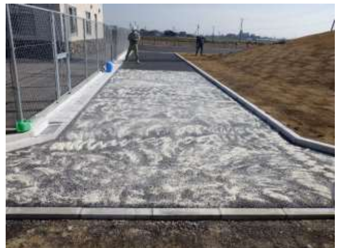
写真 1-⑧ 透・保水性舗装(ミラクルソル WG-04) 2mm アンダー散布状況
