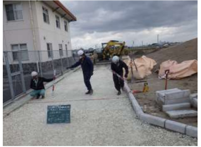
写真 1-④ 路盤の転圧完了 (出来形検測)
