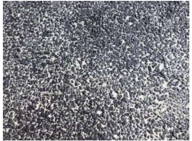
写真 1-⑩ 透・保水性舗装 2mm アンダー 間詰め完了
