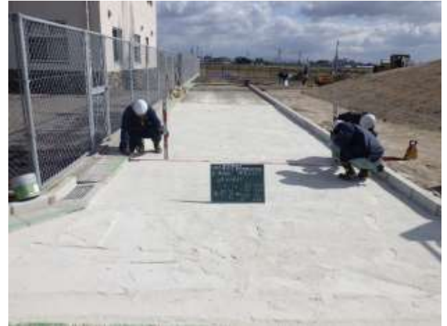
写真 1-⑥ フィルター層 2mm アンダー転圧完了 (出来形検測)
