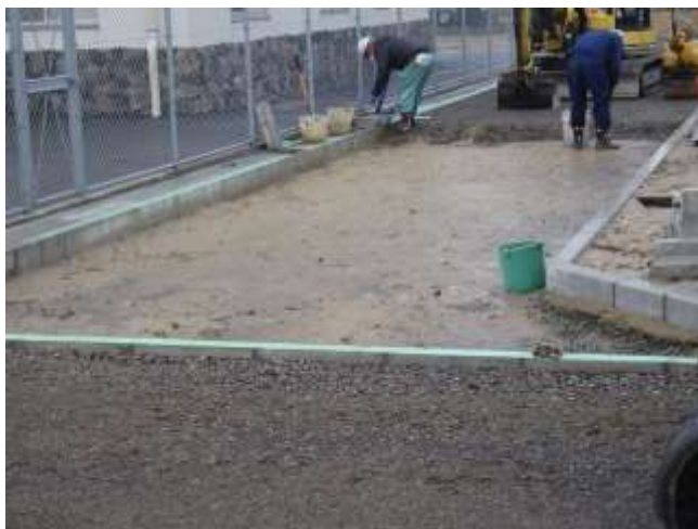
写真1-① 着工前の状況
