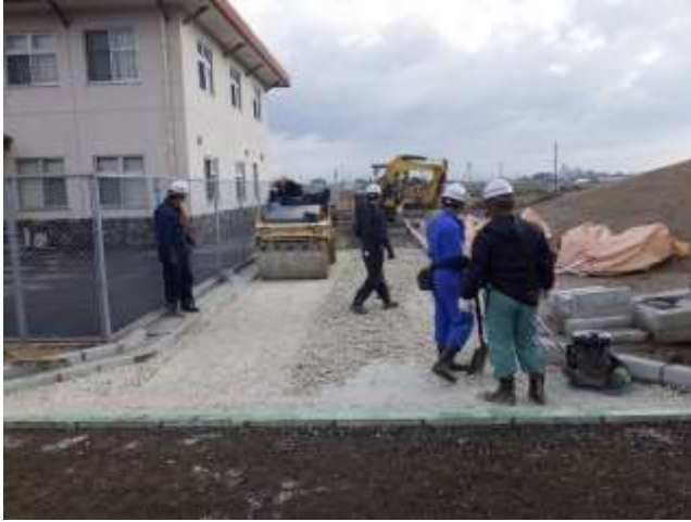
写真 1-③ 路盤(ミラクルソル WG-04) 10~50mm 転圧状況
