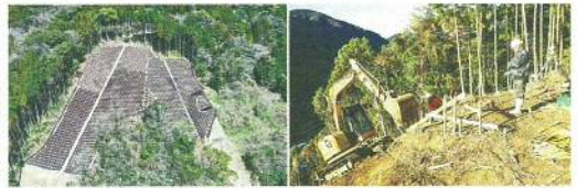
完成した鍋倉地区災害関連緊急治山事業工事
