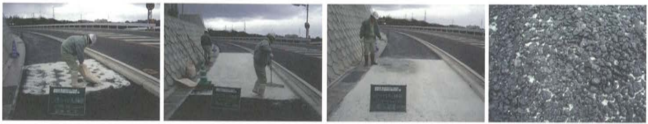
①ミラクルソル 2mm アンダー 散布状況 ②敷均状況 写真-3 アスファルト空隙への2mm アンダー間詰め材の工程 ③散布状況 ④完了
