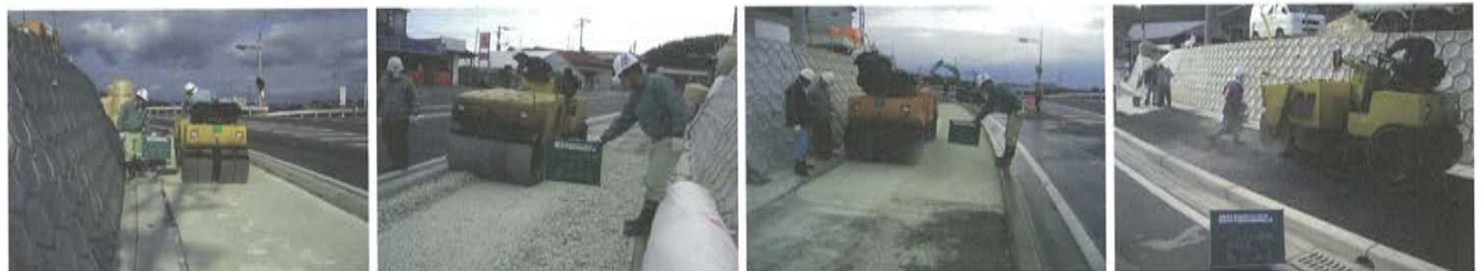
②路盤転圧 ミラクルソル φ 2-50mm
