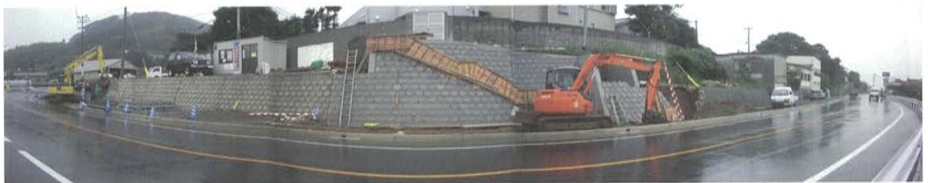
施工箇所全景
