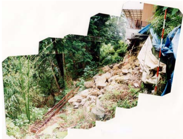
斜面崩壊状況
