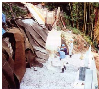
敷き均し状況
