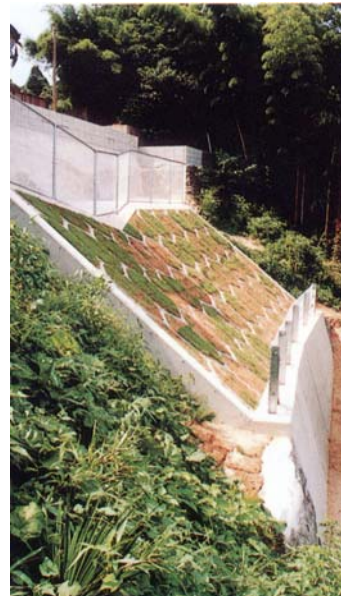
施工直後 (H12.3 完成)
