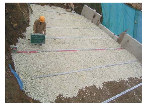
補強土壁軽量盛土
