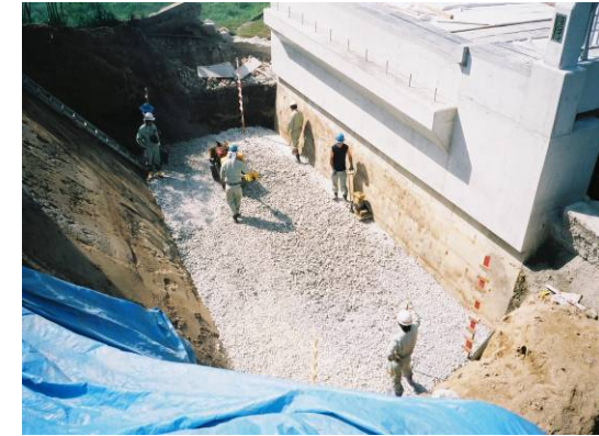
橋台背面の軽量盛土
