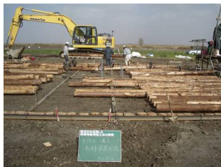
c. ラフト設置状況
