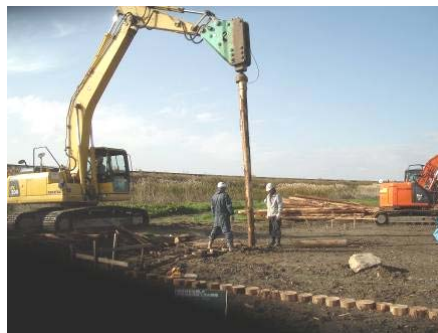
a. 木杭打込状況
