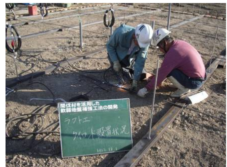
b. タイロッドおよび締付材設置状況
