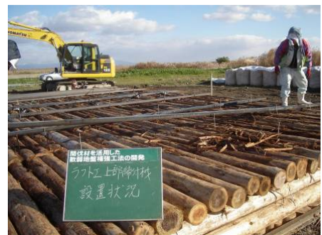
d. 締付材設置状況
