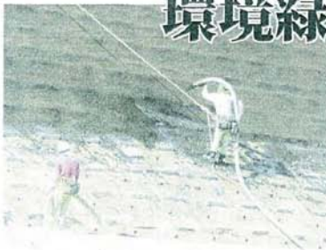
吹き付け作業のようす
