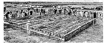
現場試験施工の様子
