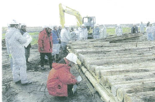
間伐材の筏基礎を見る参加者
