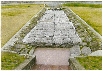
ミラクルソルを活用した水質浄化工法の施工事例(愛知県多治見市の庄内川水系土岐川支川の幸沢川)
