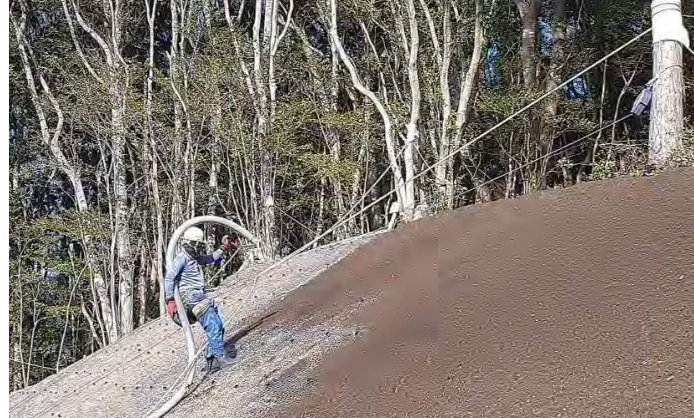
植生基盤材吹付状況
