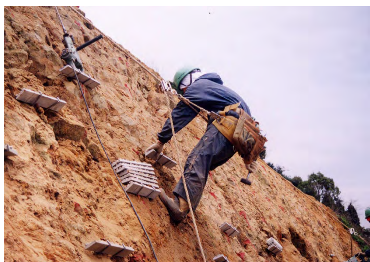
ミラクルボードの設置状況 千鳥状に配置(1枚/m 2 )
