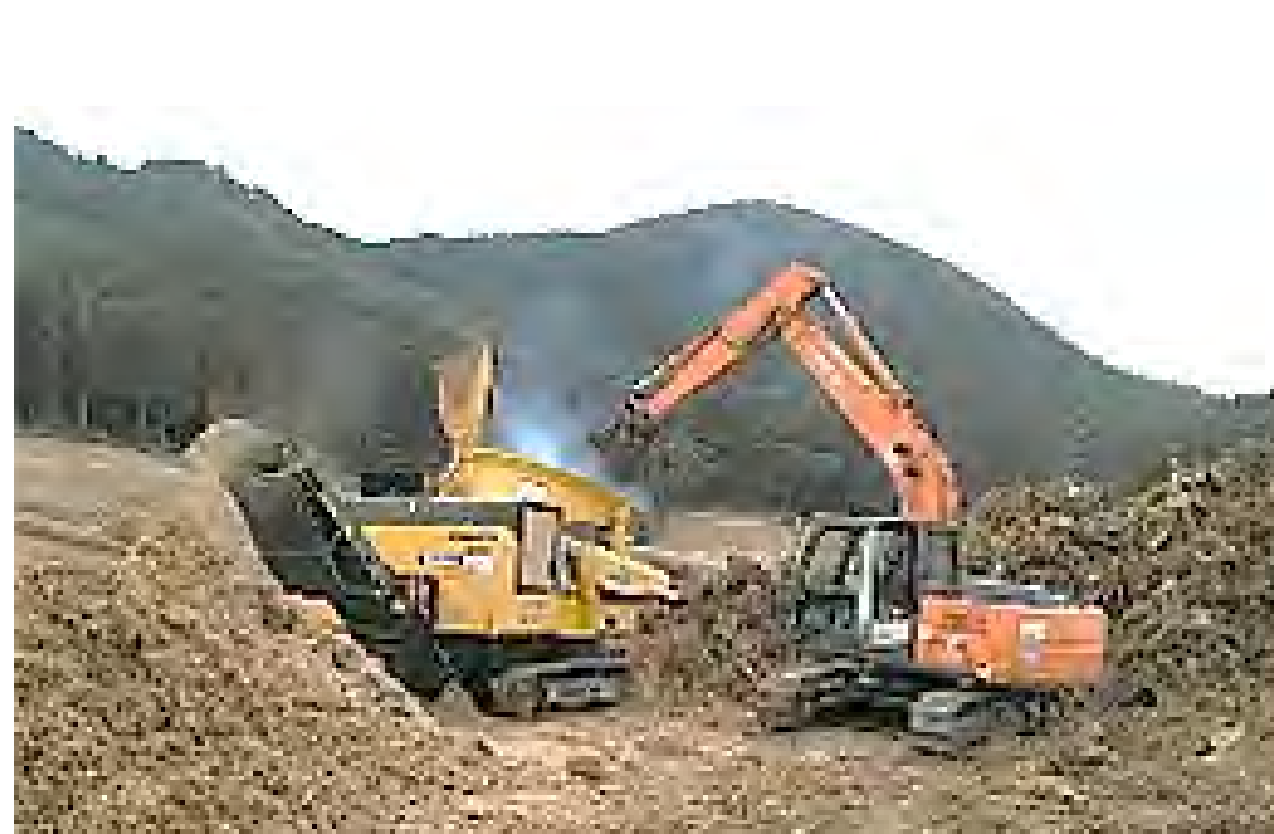
木材破砕機による破砕状況
