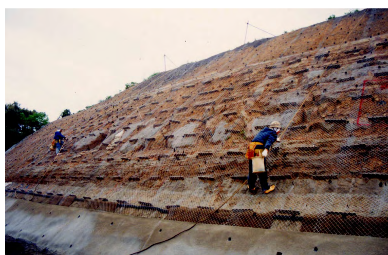
ラス張り状況
