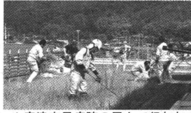
▲唐津市民病院の屋上で行われた除草作業
