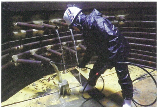
地下水の集水孔を洗浄する様子
