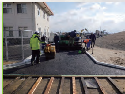
透水性アスファルトの打設
