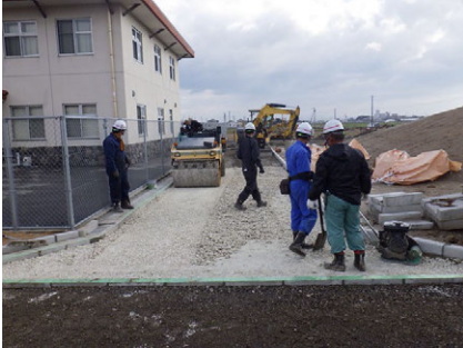
写-2 ミラクルソル 10～50mm 撒き出し及び転圧状況 (2層目)
