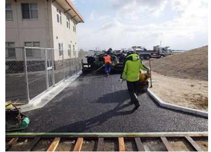
写-4 透水性アスファルト打設 及び転圧状況
