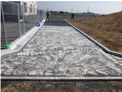
写-5 ミラクルソル 2mm アンダー 間詰め作業
