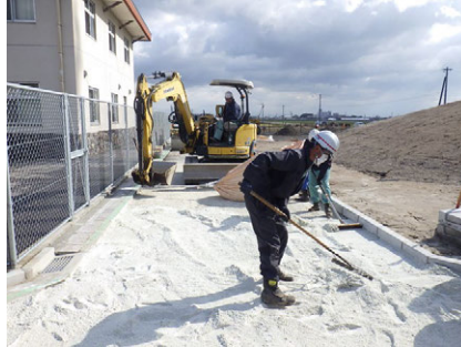
写-3 ミラクルソル 2mm アンダー 撒き出し及び転圧状況 (1層と3層目)
