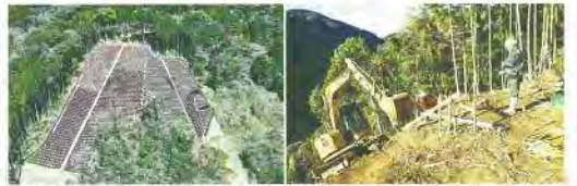
完成した鍋倉地区災害関連緊急治山事業工事
